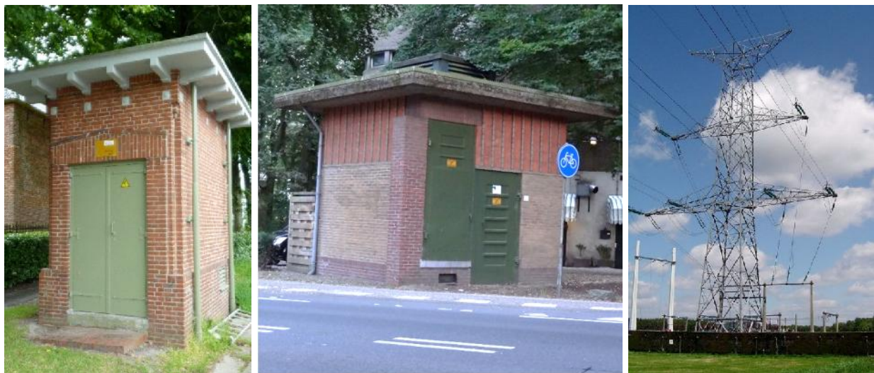
Figuur 24: Netwerkinfrastructuur, links en midden: MS/LS transformatorhuisjes (© Frans van Nes, CC BY-SA 3.0, © Ward van Wanrooij, CC BY-SA 3.0), rechts: HS/MS station (© Touhib, CC BY-SA 3.0).
