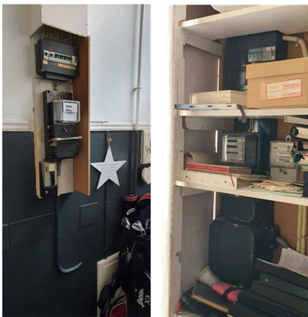
Figuur 8: voorbeeld van een huis zonder meterkast
