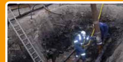
Dichtbij de leidingen wordt de grond weggezogen. Zo wordt graafschade voorkomen
