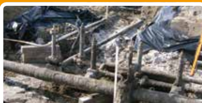
Een oud afsluiterschema is vrijgegraven
