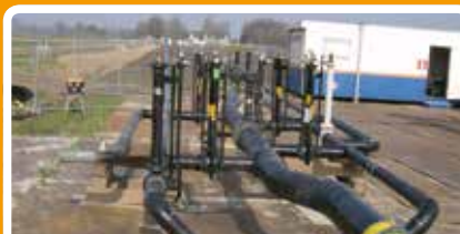
Een nieuw exemplaar is in de werkplaats gebouwd en kan in zijn geheel geplaatst worden
