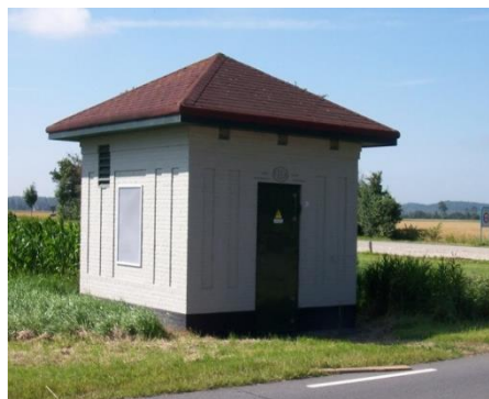
Figuur 2.4: Voorbeeld van transformatorhuisje
