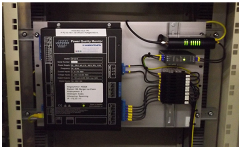
Figuur 5.2: Voorbeeld Unipower-meeteenheid en 3G-modem
