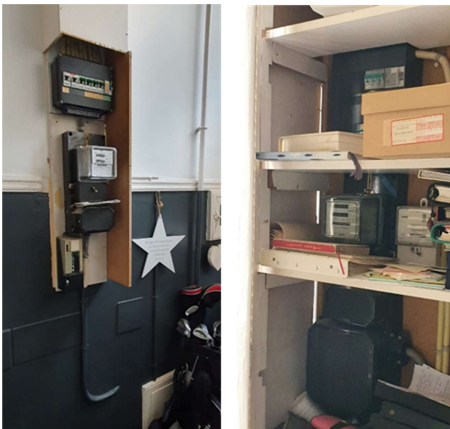
Figuur 2.8: voorbeeld van oude huizen zonder meterkast (bron: Techniek Nederland)
