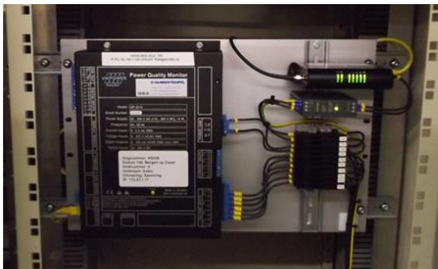
Figuur 5.2: Voorbeeld Unipower-meeteenheid en 3G-modem
